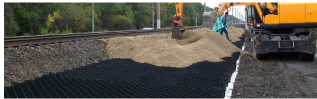
Рисунок 1. Применение геотекстиля и геосетки для равномерного распределения нагрузки на дорожное полотно
