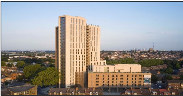
Рисунок 1 — Жилая башня Apex House, Лондон
