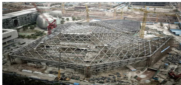
Рис.3 Оперный театр в Гуанчжоу, процесс строительства.
